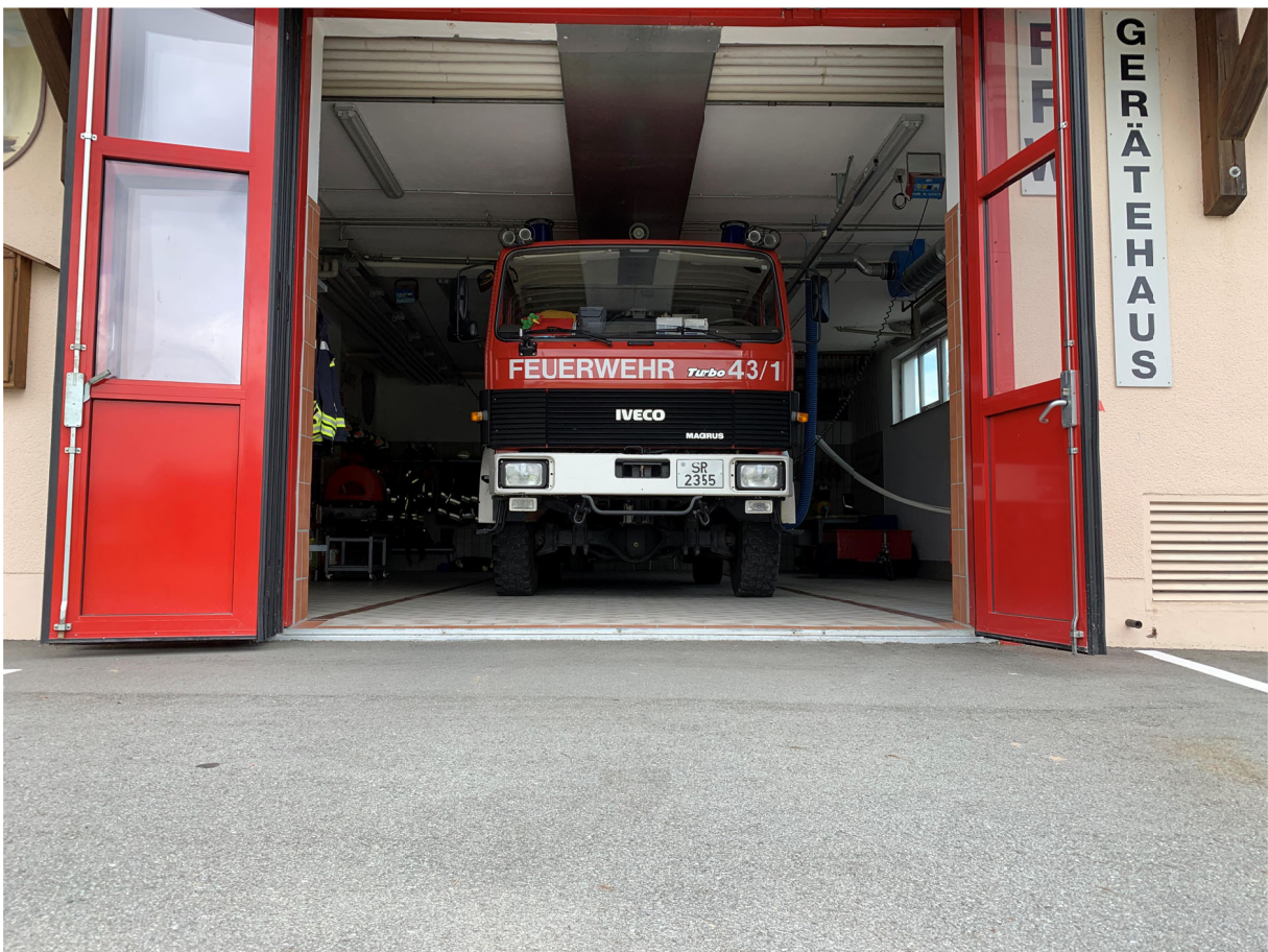
Der Boden im Haselbacher Feuerwehrhaus muss um einige Zentimeter tiefergelegt werden.
